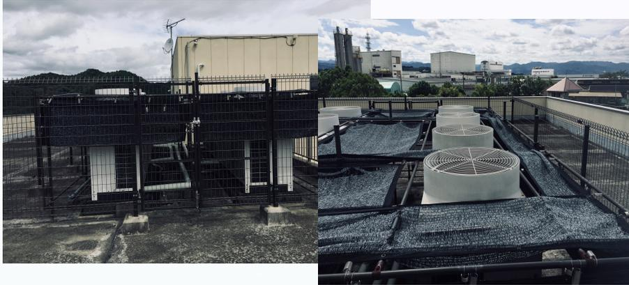
室外機筐体に「高乱反射非中空遮熱塗料」チルコートHSPを塗装することで消費電力の削減でき更に**安全**である。
