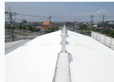
(A)南側屋根スレート表面の温度は施工前が、63.5°C、施工後が39.4°Cと**-24.1°C**の差が出ている。
