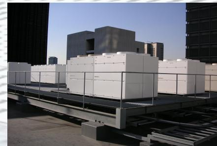
また、建屋以外にも設備機器にも「熱吸収・蓄熱」しない、遮熱塗料は有効です。特に、夏期における空調冷房運転は、太陽光の影響により屋外設置の外調機(室外機)の運転効率が極端に低下し消費電力が増え、又、故障発生率も増加し、耐久年数に影響を与える。空調機の節電及び耐久年数向上対策は、熱交換システムの負荷を下げる事が必要です。
