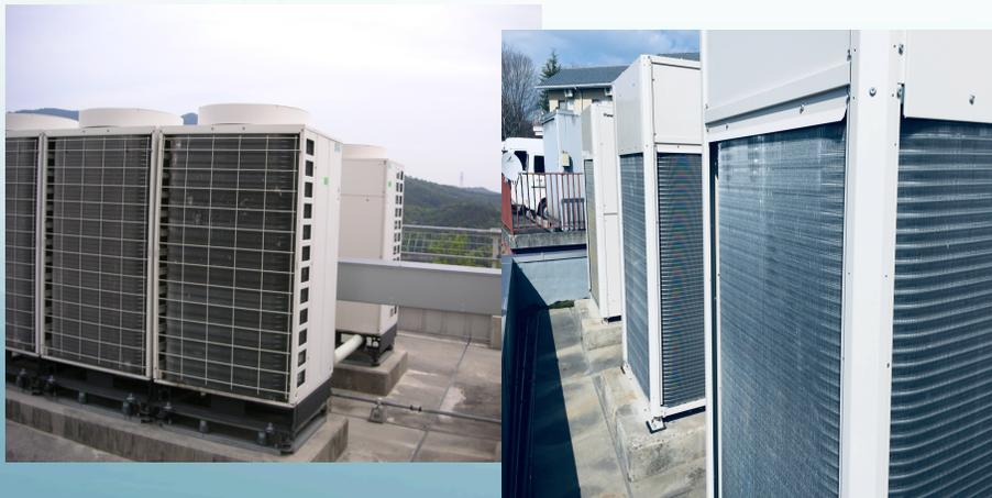
高乱反射非中空遮熱塗装仕様の「チルーバー」(特許申請済)を取り付けることで熱交換器の性能を維持する。
